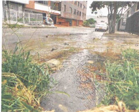
Desperdicio. Se estima que en un daño de acometida (tubería menor de 2 pulgadas) cada hora se pierden 3000 litros de agua (igual a 3 metros cúbicos).
