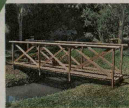
Puente fabricado a partir de plástico reciclado, con apariencia de madera.
