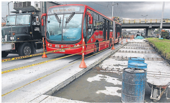
Reparación de losas de TransMilenio en la troncal de la autopista Norte. Archivo / EL TIEMPO
